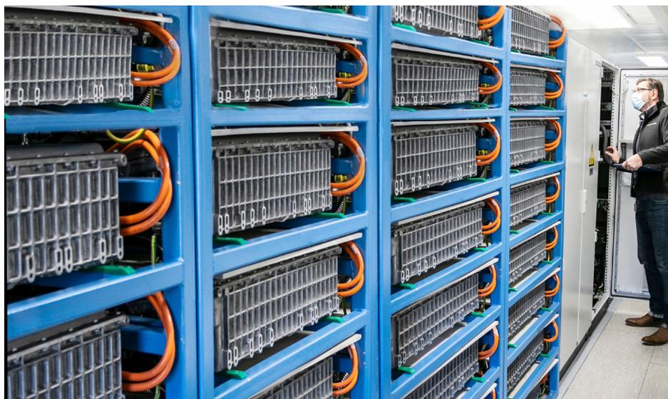
La seconde vie comme méthode de valorisation de batteries automobiles : malgré une réduction de la capacité, les batteries peuvent servir d'accumulateurs décentralisés. Cette application permettra de stabiliser la production et le stockage de sources alternatives. Photo: Mercedes-Benz
